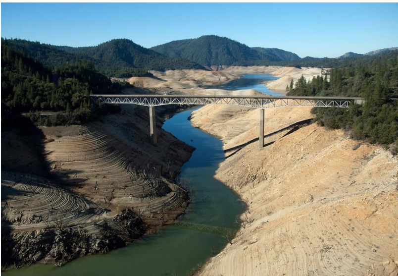
Abb. 2: Enterprise Bridge über den Lake Oroville, 16.1.2014
