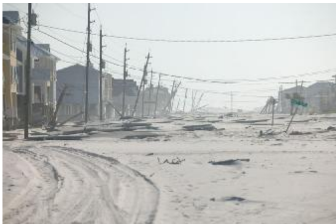
Abb.4: Navarre Beach, Fla., 11. Juli 2005 – entstandener Schaden durch den Hurrikan Dennis, Quelle: Booher, A., FEMA (2005): http://commons.wikimedia.org/wiki/Image:Damage_caused_by_Hurricane_Dennis_2005.jpg (27.10.2007)
