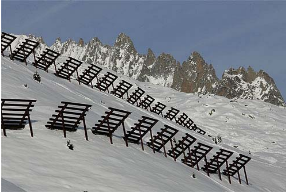
Abb. 6: Schutzbau gegen Lawinen
